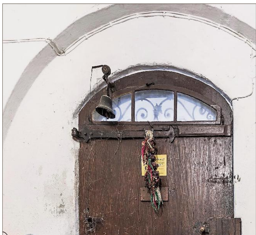
Überall im Mauerwerk finden sich Bögen, was nahelegt, dass selbst die Öffnung um diese alte Tür einmal ein hohes Portal gewesen sein könnte.
