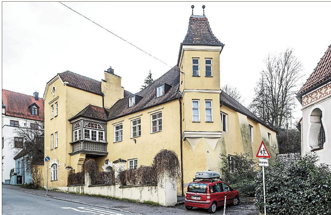
Ob es sich beim neoromantischen Gebäude Alte Bergstraße 157 um einen Neubau aus dem Jahr 1877 handelt, wird bezweifelt. Ein massiver Bau ist an dieser Stelle bereits im Sandtner-Modell erkennbar. Fotos: Peter Litvai
