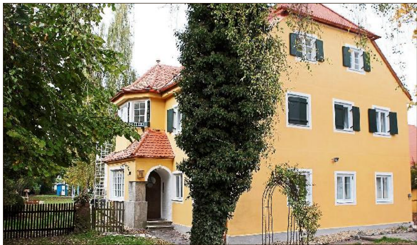
In neuem Glanz erstrahlt das Wohnhaus des Griesenbecker Hofes, das seit Oktober ein Mutter-Kind-Haus beherbergt. Foto: LZ-Archiv/cv
