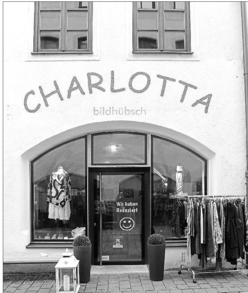
Erst vor wenigen Jahren wurde der Geschäftseingang wieder auf die ursprüngliche Situation zurückgeführt. (Fotos: Christine Vinçon)
