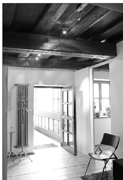
Durch das erste Obergeschoss zieht sich eine alte Holzbalkendecke.
