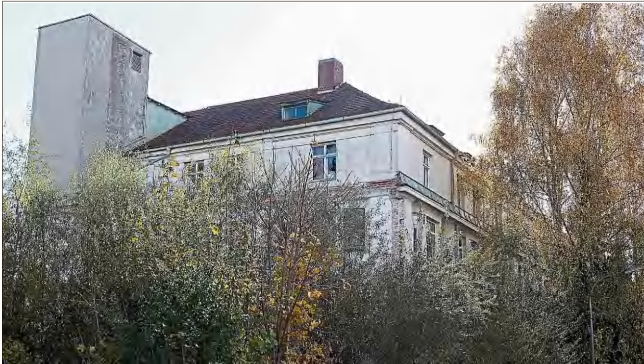
Ein Dickicht aus Unkraut und Sträuchern umgibt die seit langem leerstehenden Gebäude. (Fotos: Christine Vinçon)
