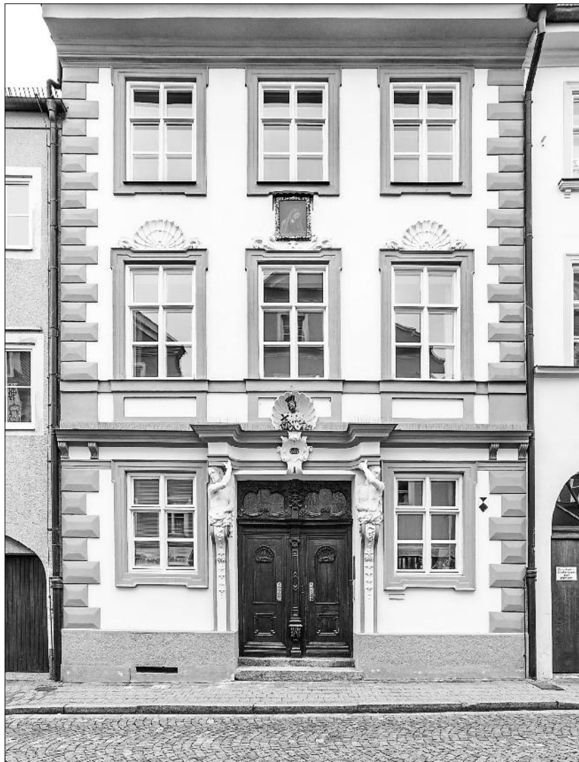
Kirchgasse 232 war bereits Mitte des 17. Jahrhunderts ein Pfarrhof. Das Gebäude ist ein einzigartiges Beispiel für die kulturelle Blüte jener Zeit.
