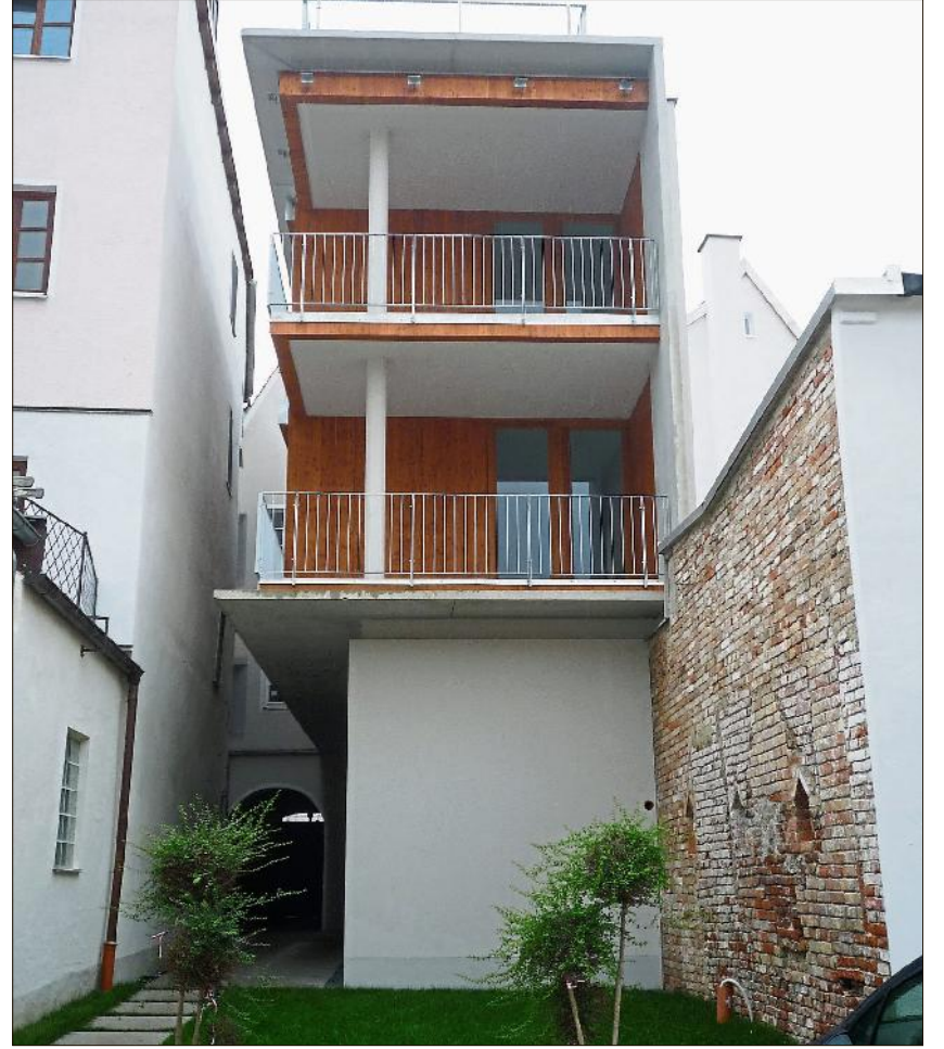
Ein moderner Anbau auf der rückwärtigen Seite des Hauses sorgt für zusätzliche Lichtquellen. Dafür wurde ein historisch unbedeutender Gebäudetrakt abgerissen. (Fotos: Napholtz, Hackl, Röder)
