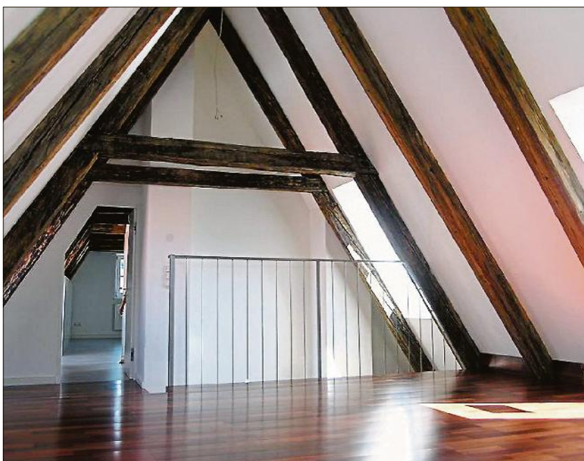
Das Dachgestühl stammt zum größten Teil noch aus dem Mittelalter.
