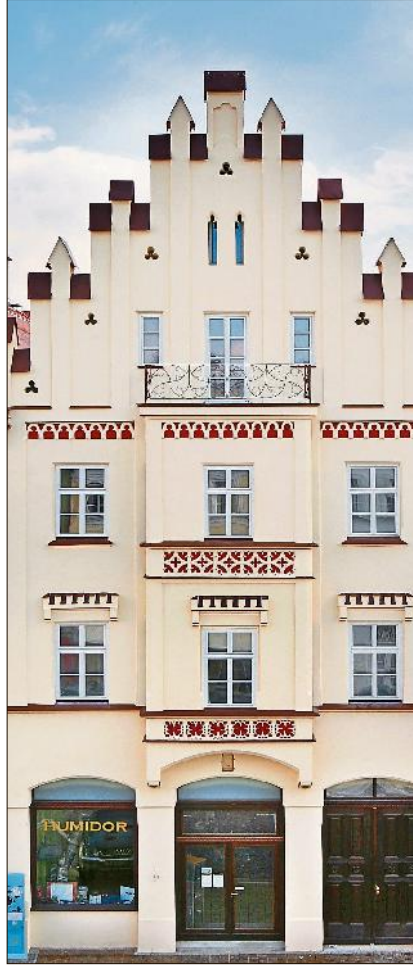
Bei der Sanierung wurden die besonderen Akzente des Maßwerks an der Fassade betont.
