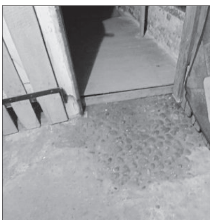
Reste eines Katzenkopfpflasters im Keller, der einst das Erdgeschoss war.
