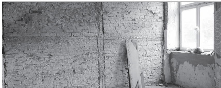
Die historische Mauerstruktur soll auch nach der Sanierung erhalten bleiben.
