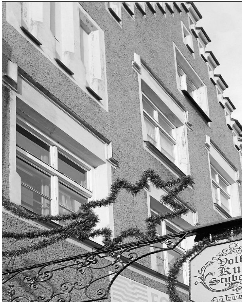
Die Fassade mit ihrem treppenartigen Ziergiebel sollte erhalten bleiben. Ansonsten war das Haus bereits zum Abriss freigegeben. (Foto: cv)
