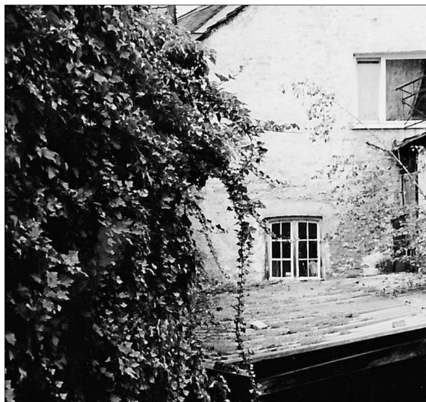
Efeuüberwuchert zeigte sich der gesamte rückwärtige Gebäudeteil zu Beginn der Sanierung.
