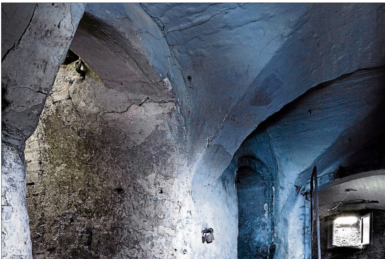
Die Kellerräume sind zum Teil möglicherweise noch von den Vorgängerbauten erhalten.
